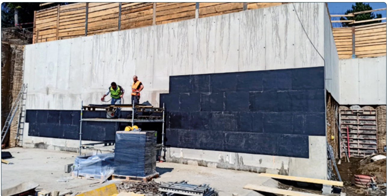
Montage aan een draagwand
