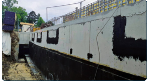
Montage aan de kelderwand
