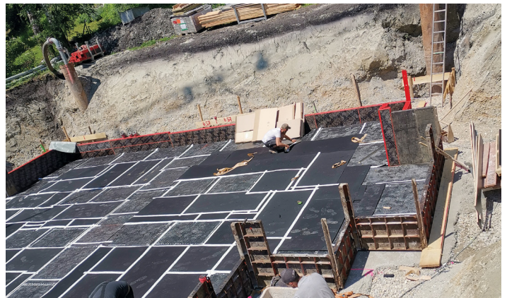
Halfvrijstaand huis in Gröbenzell, Cimax® is onder de dragende muren gelegd vanwege het grondwater
