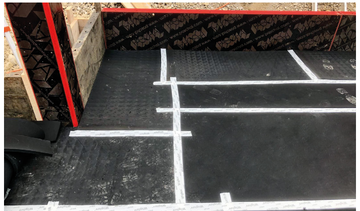
Eengezinswoningen in Gräfelfing, plaatsing van Cibatur® in één en twee lagen onder de vloerplaat
