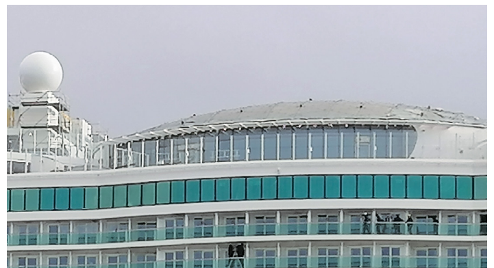
Gemonteerde schuifplaten aan de onderkant van het dak
