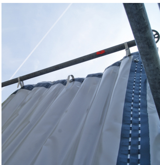
Foto 4: Bevestiging en uitlijning
