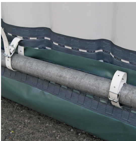
Foto 8: Bevestiging van sleepstrip aan steigerpaal
