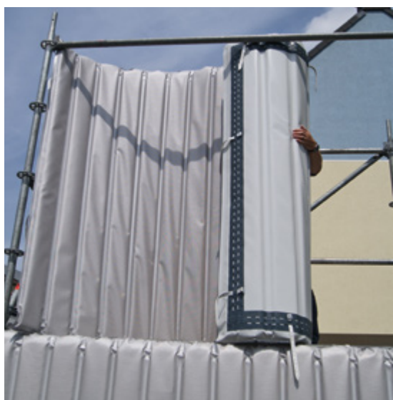
Uitrollen aan de steiger
