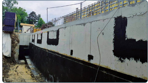
Montage aan de kelderwand
