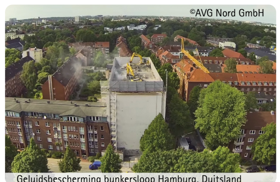
Geluidsbescherming bunkersloop Hamburg, Duitsland
