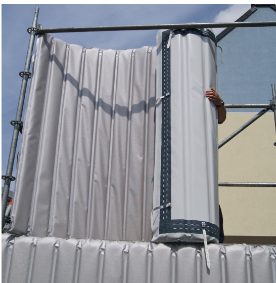
Uitrollen aan de steiger
